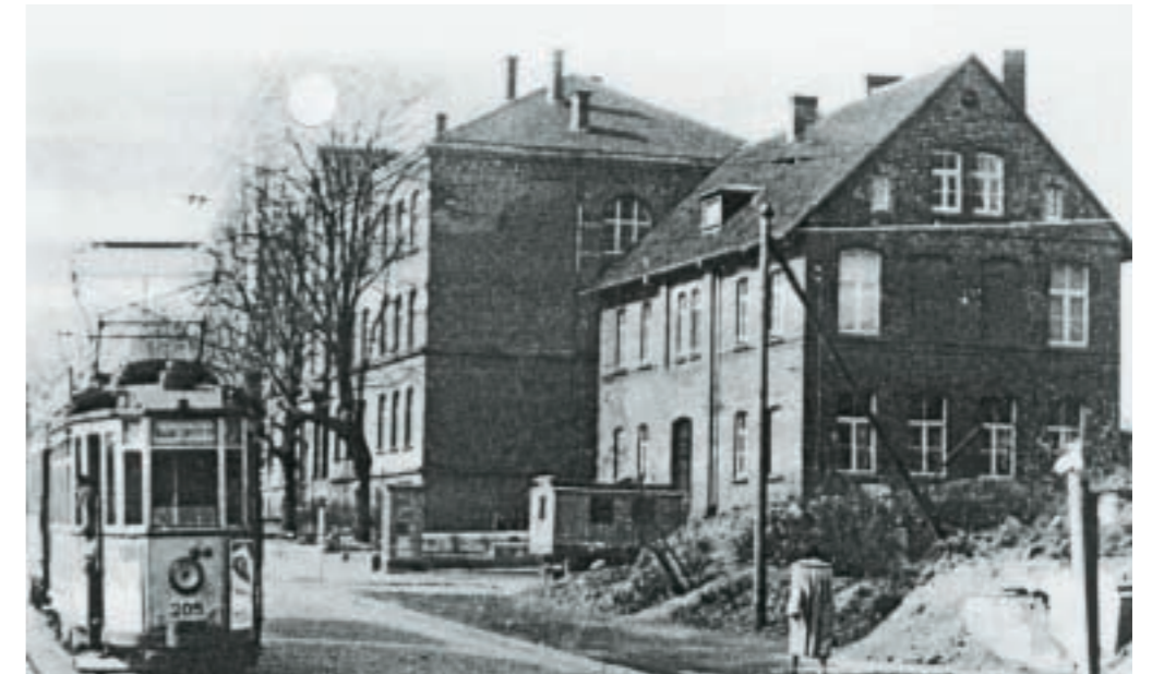
Der Wiederaufbau beginnt. Die Straßenbahnlinie 7 ist von der ehemaligen Gaststätte Rumpf bis zur Wendeschleife in der Engelhardstraße verlängert worden. Rechts der Bau der alten Volksschule und die wieder eingedachte Bürgerschule 24. (F. Hartmann)
