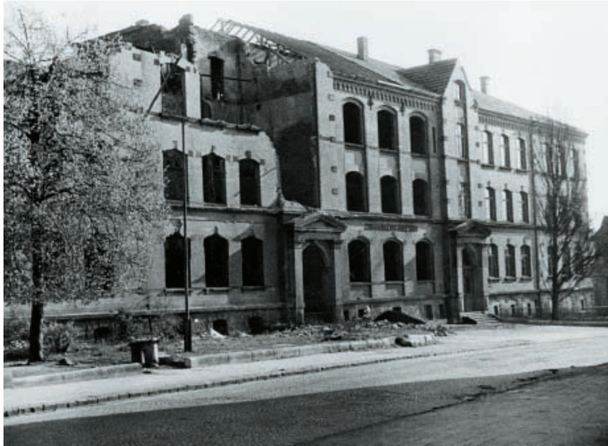
Der östliche Trakt der Bürgerschule 24 ist samt Treppenhaus wieder aufgebaut, während der Mitteltrakt und die westliche Bürgerschule 23 noch in Trümmern liegen. (F. Hartmann)
